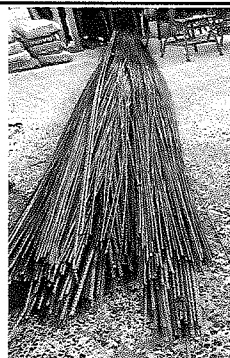
HIERRO UTILIZADO PARA CONSTRUCCIÓN DE MURO PERIMETRAL.
