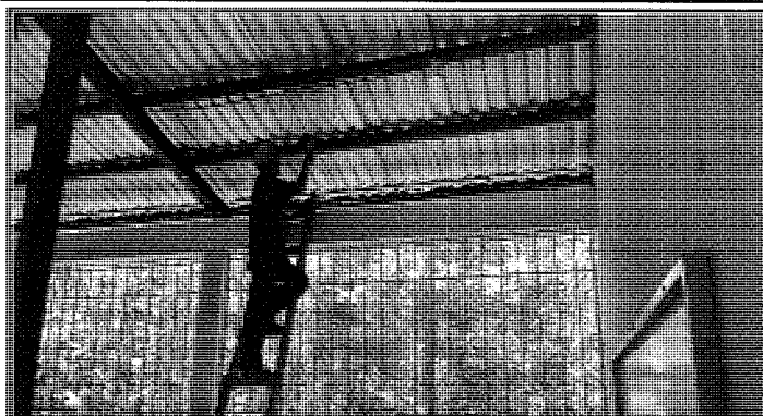
LIJADO DE LA ESTRUCTURA METÁLICA, EN UNO DE LOS SALONES DE NUESTRA ESCUELA.
