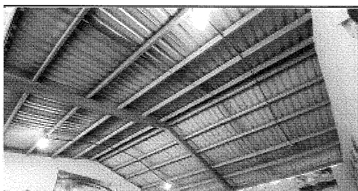
SEGUNDA MANO TERMINADA DEL PINTADO DE LA ESTRUCTURA METÁLICA, PENDIENTE AÚN LA TERCERA MANO.
