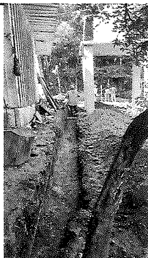
INICIO DEL ZANJE, PARA EL MURO PERIMETRAL.
