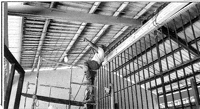
LIJADO Y PINTADO DE LA ESTRUCTURA METÁLICA DEL TECHO.
