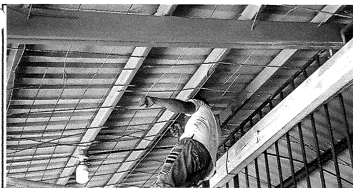
PINTADO DE LA ESTRUCTURA METÁLICA DEL TECHO DE NUESTRO ESTABLECIMIENTO.
